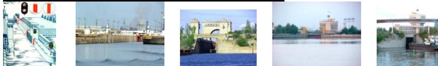
**Шлюз** состоит из камеры и подходных каналов к этой камере. Массивные передняя и задняя части камеры шлюза называются головами шлюза – с воротами и системами наполнения/опорожнения (*течения!*). Для швартовки в камере шлюза применяют плавучие рымы, которые перемещаются в вертикальной стенке камеры заодно с судном.
