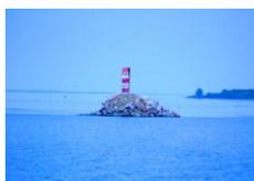
На водохранилищах могут применяться **русловые маяки** - разновидность знака "Ориентир" - расположенные на открытой акватории на искусственных основаниях. Они указывают точки поворота судового хода и являются надежным средством для определения места судна.
